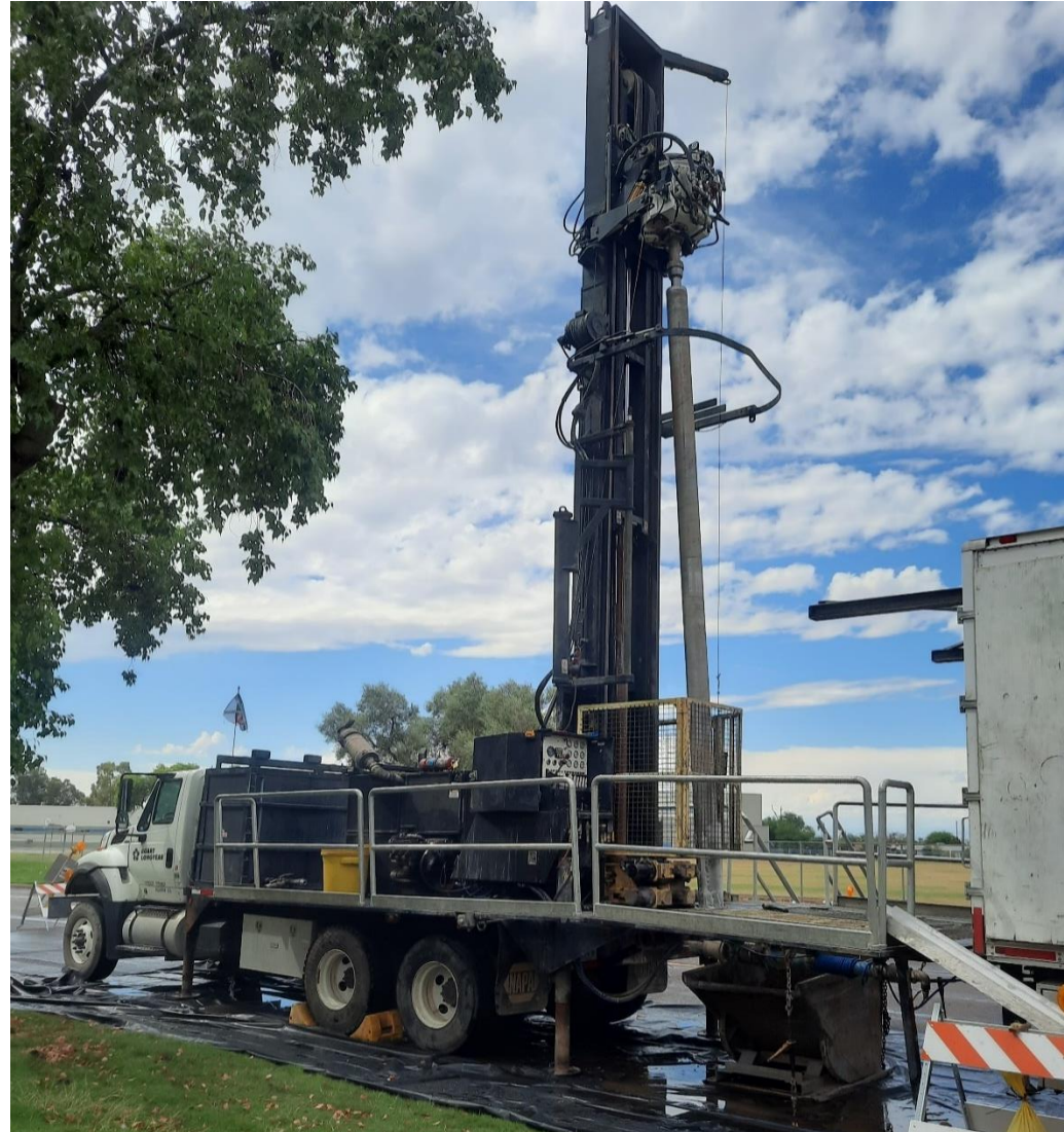
Drilling a Groundwater Monitoring Well on 45 th Ave Perforación de pozos de monitoreo de agua subterránea por 45 th Ave
