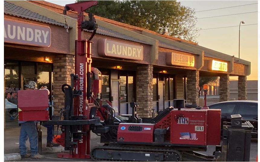
Active Soil Vapor Sampling / Muestreo de vapor de suelo activo
