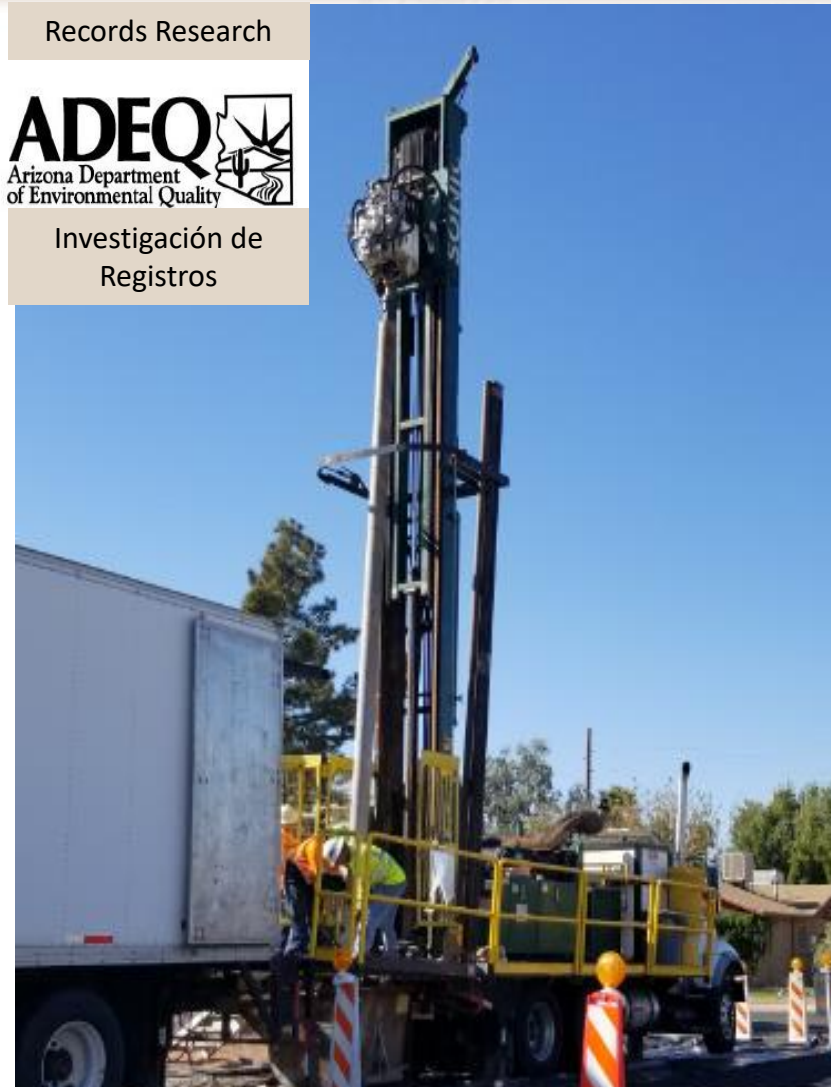
Sonic Drill Rig and Support Truck, Groundwater Monitoring Well Installation / Equipo de perforación sónica y camión de apoyo, instalación de pozos de monitoreo de aguas subterráneas
