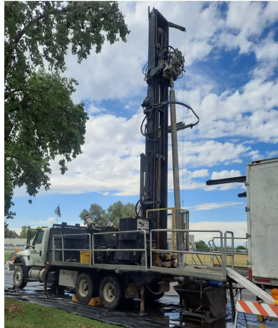
Sonic Drill Rig and Support Truck, Groundwater Monitoring Well Installation / Equipo de perforación sónica y camión de apoyo, instalación de pozos de monitoreo de aguas subterráneas
