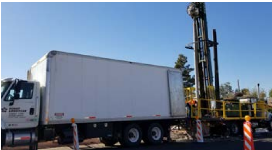
Instalación de pozos de monitoreo de agua subterránea en el sitio WQARF de 51st Avenue y Camelback Road.
